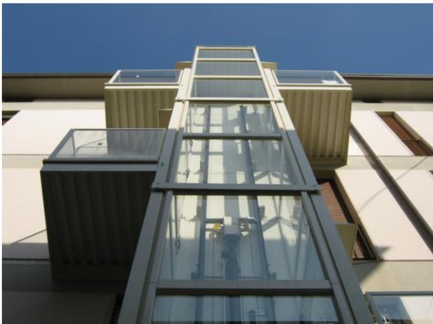
Qui a lato un esempio di inserimento di un elevatore in un edificio preesistente con creazione di sbarchi per l'ingresso nelle abitazioni. Sopralluogo, studio della soluzione e formulazione di un preventivo "chiavi in mano" sono gratuiti.
